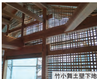
手刻みによる部材仕口継手
