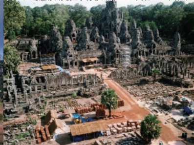
バイヨン北経蔵の修復工事現場の様子1996年頃(1999年竣工)
