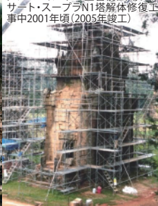
アンコール・トム王宮前広場ブラサート・スーブラN1塔解体修復工事中2001年頃(2005年竣工)
