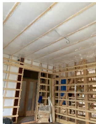
天井の改修風景
