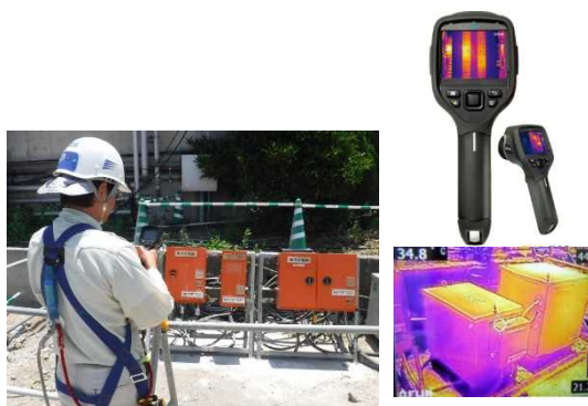
サーモグラフィーの活用
