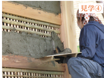
竹小舞下地荒壁付け作業
