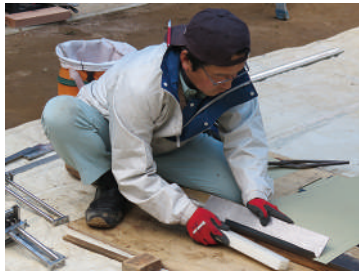
板金屋根・水切り設置作業
