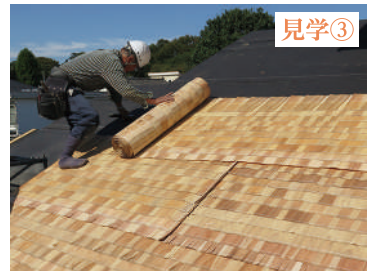
トントン下葺き和瓦葺き作業
