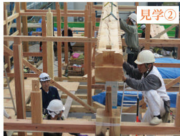
木組みの架構 建て方作業
