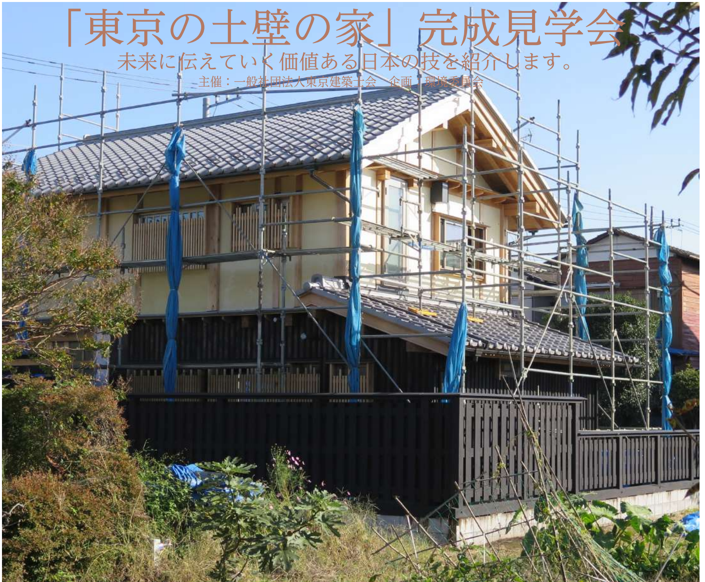
2018年10月22日撮影 北側・西側の建物外観と大和堀
