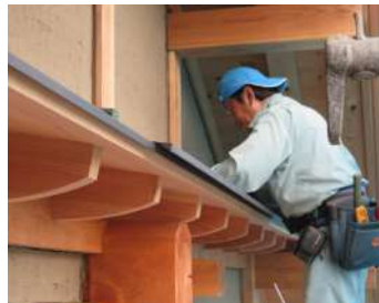
8月21日 妻壁板庇の水切板金取付
