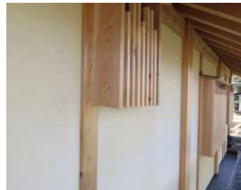
10月22日 土佐漆喰金鍍押えの外壁
