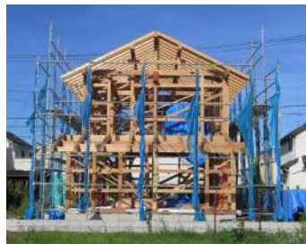
6月30日 上棟時の架構全景
