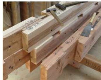
6月19日 手刻み加工による部材継手
