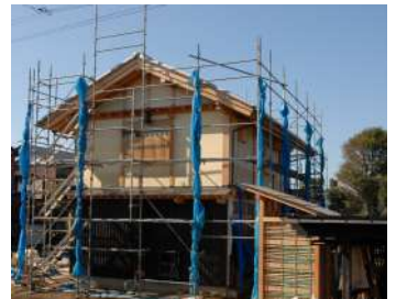
10月22日 足場撤去直前の東側外観
