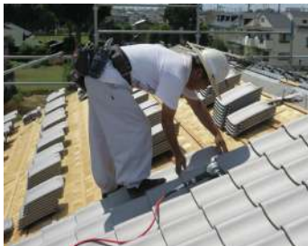
7月13日 トントン下地燻銀和瓦葺き
