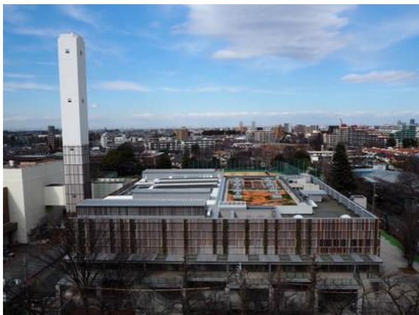
最新鋭のプラント設備を導入し、環境の保全に配慮したごみ処理施設の見学会です。建物全体は、法に定める耐震基準の1.25倍として、耐震解析モデルにより設計されています。さらに、プラットホーム地下化に伴い、柱を無くしたトラス構造を採用しています。また、煙突は再利用し、耐震補強により耐震基準1.25倍が確保されています。また、周囲の景観にも配慮し、武蔵野の雑木林をイメージした外観デザインとなっています。焼却炉でゴミを燃やした熱を利用して、電気と蒸気を生み出し、クリーンセンター内で使用するほか、周辺公共施設にも供給しており、地域エネルギー供給拠点としての役割も担っており、災害に強い中圧ガス管から供給を受けているガスコージェネレーションを備え、ゴミ発電の補助装置としての機能、災害時の再稼働装置としての機能を持っています。
