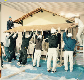
8 - パネル化した土間底の取付け
