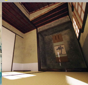
9 - 完成した室内の様子 土壁の上に腰紙貼り
