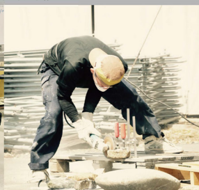
4 - 展示物として軽量化のため東石、差石の切断
