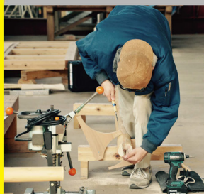
2 - 大学実習場内での木工班による柱仕口加工
