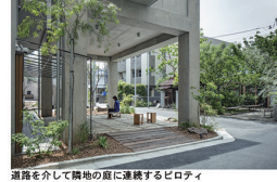
道路を介して隣地の庭に連続するピロティ
