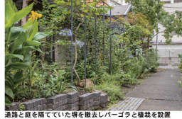
道路と面を隔てていた柵を撤去しパーゴラと緑帯を設置
