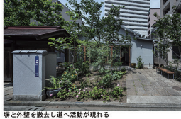
柵と外壁を撤去し道へ活動が促される
