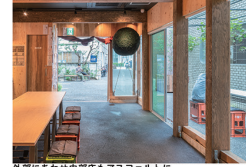
外部にあわせ内部床もアスファルトに
