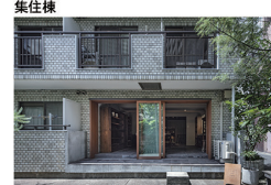
手摺り壁を撤去しバルコニー側を入りに
