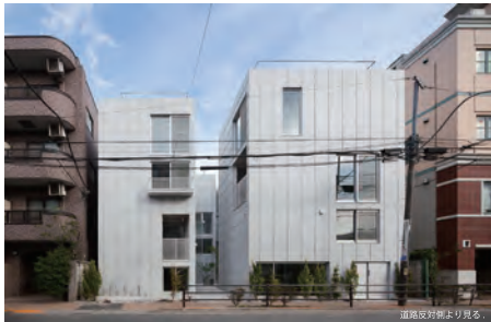
道路反対側より見る。
