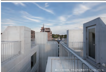
屋上 1 つは井戸。それ以外は専用のテラスになっている。
