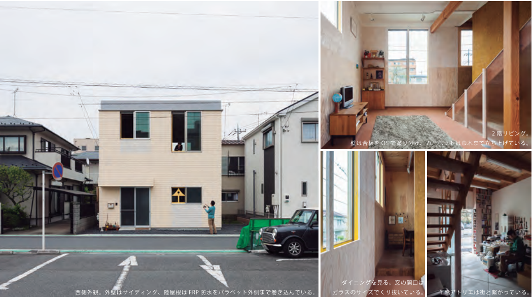
西側外観。外壁はサイディング、陸屋根は FRP 防水をバラベツト外側まで巻き込んでいる。
