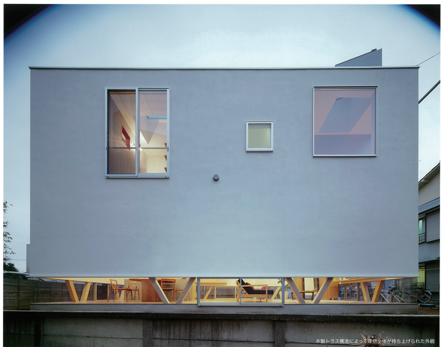
木製トラス構造によって建物全体を持ち上げられた外観
